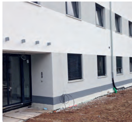
Die Außenfassade ist fertig. Nur das Vordach muss noch angebracht werden.
