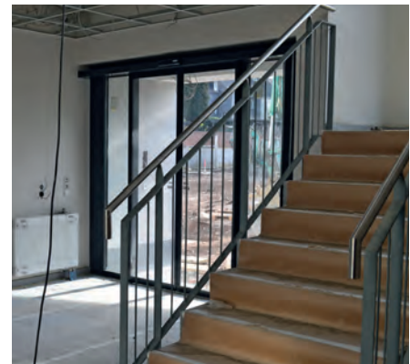
Die automatische Schiebetür und der ebenerdige Zugang ermöglichen einen behindertengerechten Zugang.
