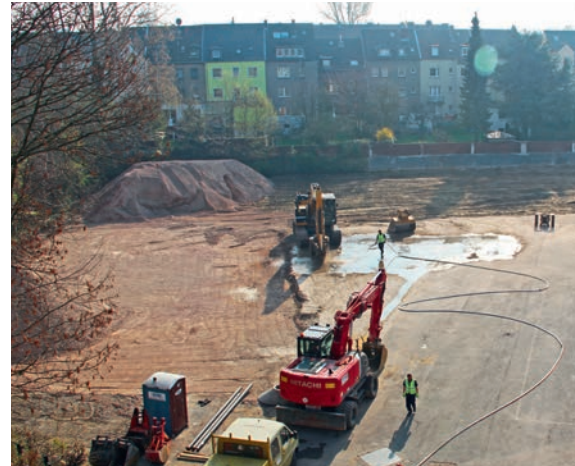
Die Vorbereitungsarbeiten sind abgeschlossen, so dass nun bald mit dem Rohbau begonnen werden kann.
